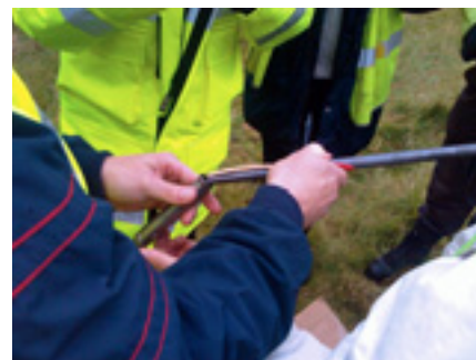
Cu-linen låses fast imellem den hærdede stålspids og forrøret
