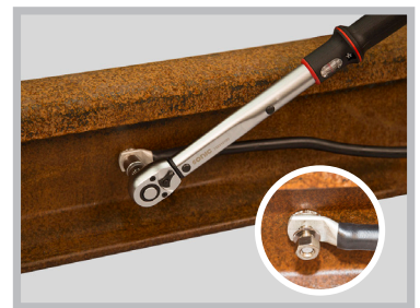
Placer kablskoen på boltens. Brug altid de medfølgende skiver og møtrikker samt momentnøglen iht. anbefalingerne.
