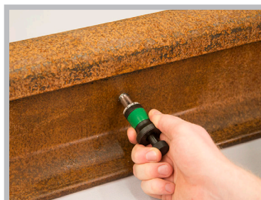
Skrue Railbond fast på forstykket af montageværktøjet og før den ind i det nye, borede hul.
