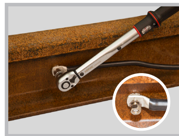
Placera kabelskon på bulten. Använd medföljande bricka samt mutter och momentnyckel alltid enligt rekommendationer.
