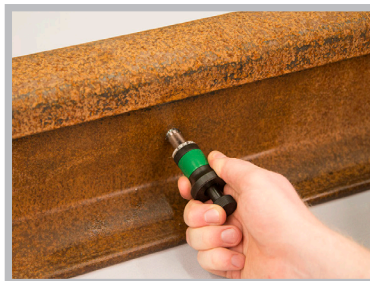
Skruva fast Railbonden på framstycket av monteringsverktyget och för in denna i det ny borrarade hålet.
